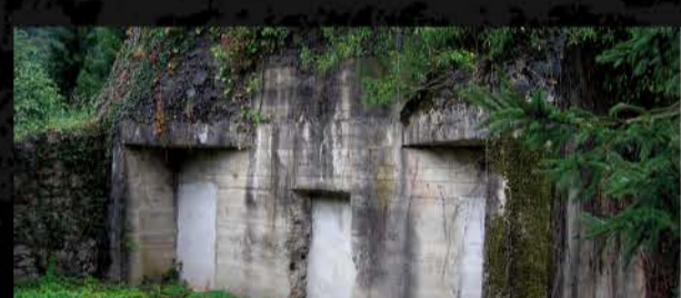
Exterior del refugio de Orrín (Infiesto)
