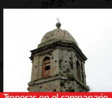
Trincheras en el campanario de San Martín de Laspra
