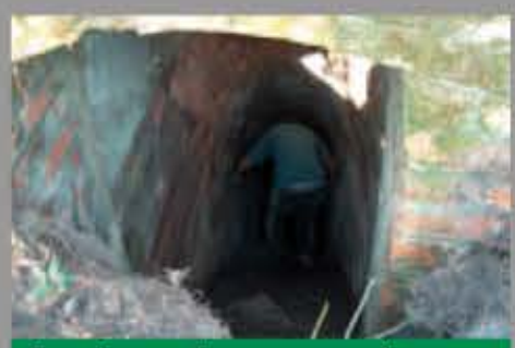
Escaleras de acceso a los subterráneos de la batería de Las Matas.
