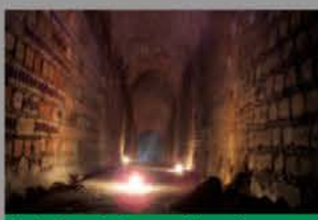
Interior de los subterráneos de la batería de Las Matas.
