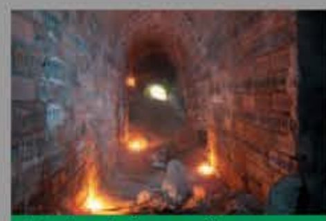
Interior de los pasillos subterráneos de la batería de Las Matas.
