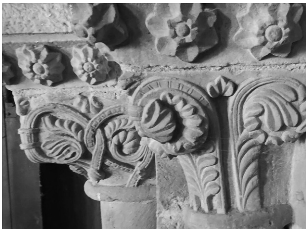
Detalle capitel de la portada del siglo XII. Acceso del claustro a la iglesia
